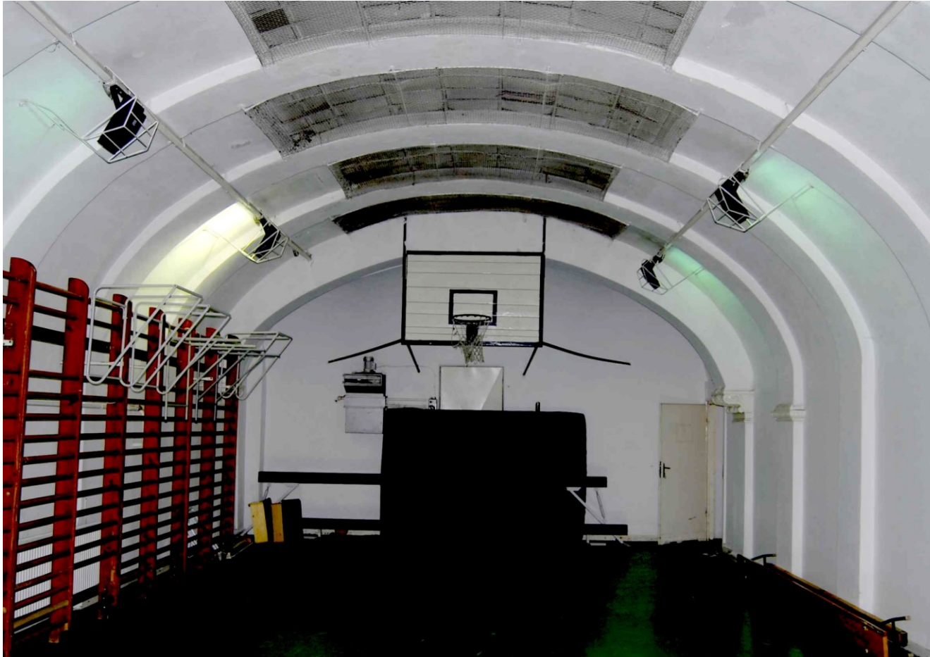
Hevederekkel erősített kosáríves vasbeton kosáríves dongaboltozat.
