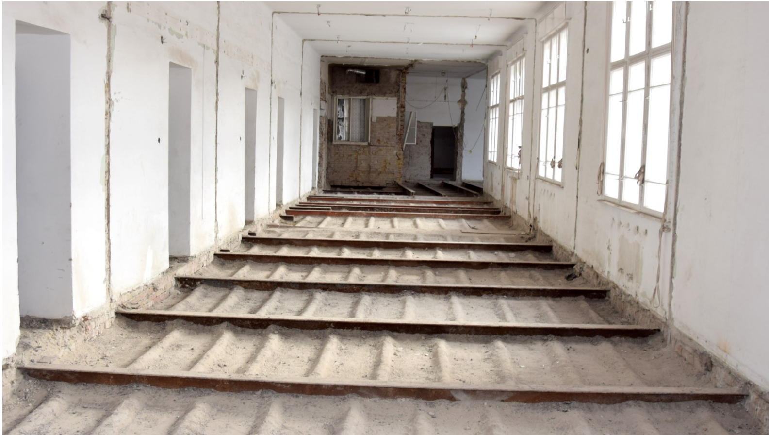
Melocco Péter féle Concrét (bordás) födém
