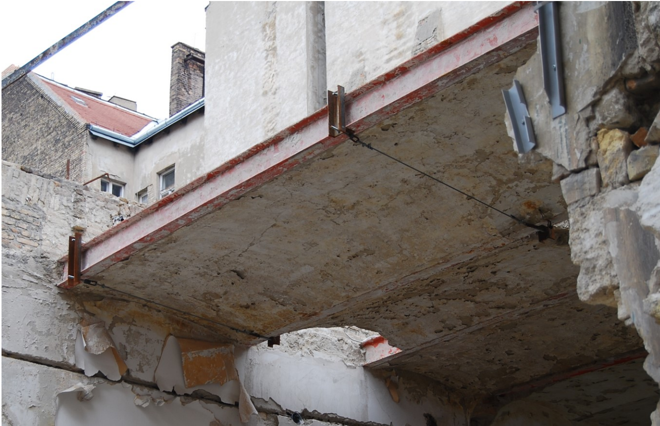
Poroszsüveg boltozat bontása
