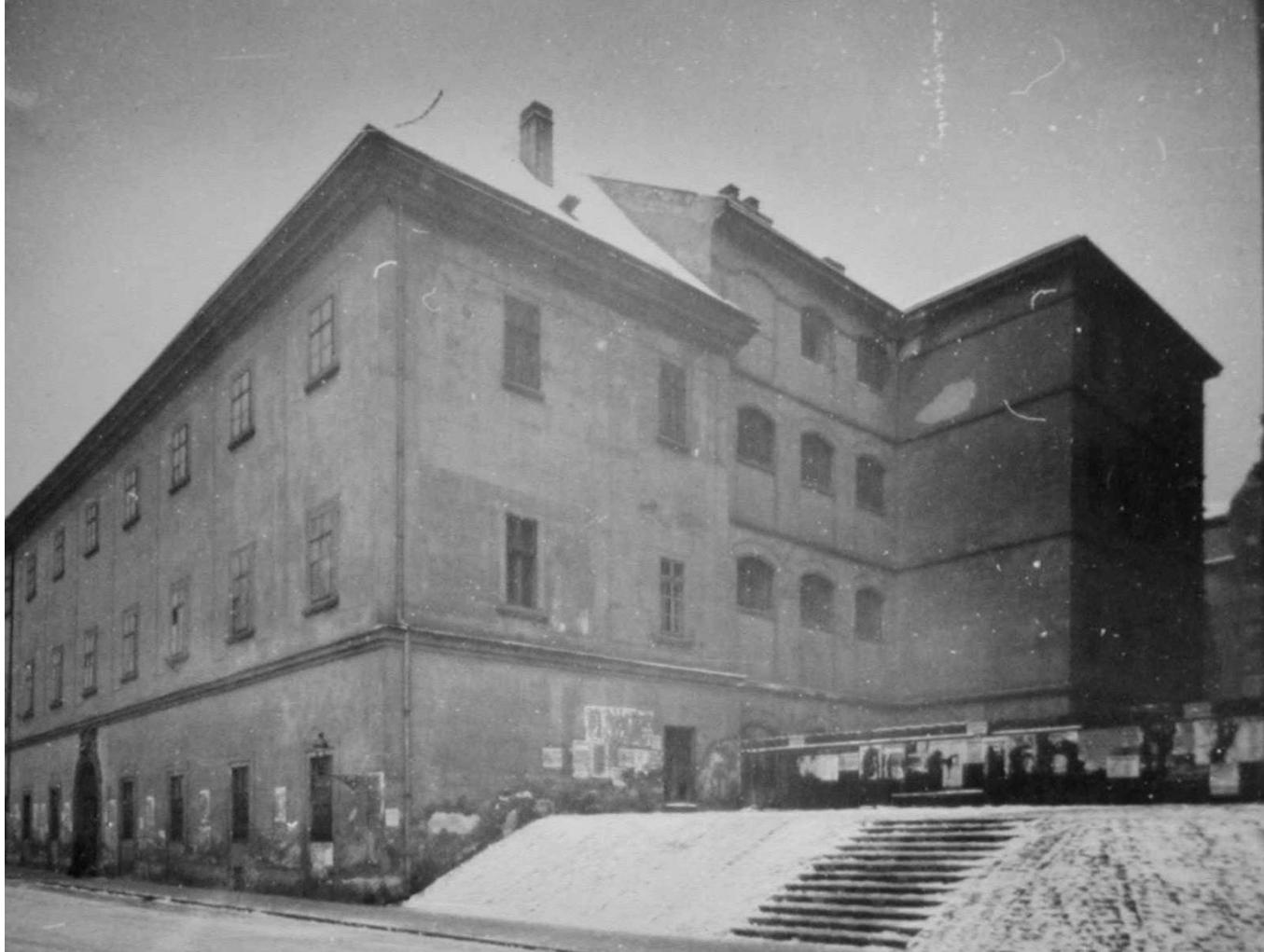
A régi piarista rendház maradék épülete, az új rendház felépülte után, 1916-1934 között. Az épületben működött az első világháború után a Népjóléti Minisztérium.
