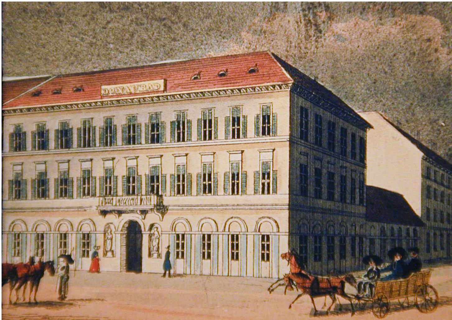
Széchenyi tér 3. egykori Diana-fürdő (3.), építtető: Ignaz Pfeiffer és neje /1822-1823, gőzfürdővé alakítás, építtető: ifj. Pfeiffer Ignác /1854, átalakítás, tervező: Gerster Károly és Frey Lajos /1864, +1 emelet rá, építtető: Kramer Samu, terv és kivitel: Medek J. Vince /1879
